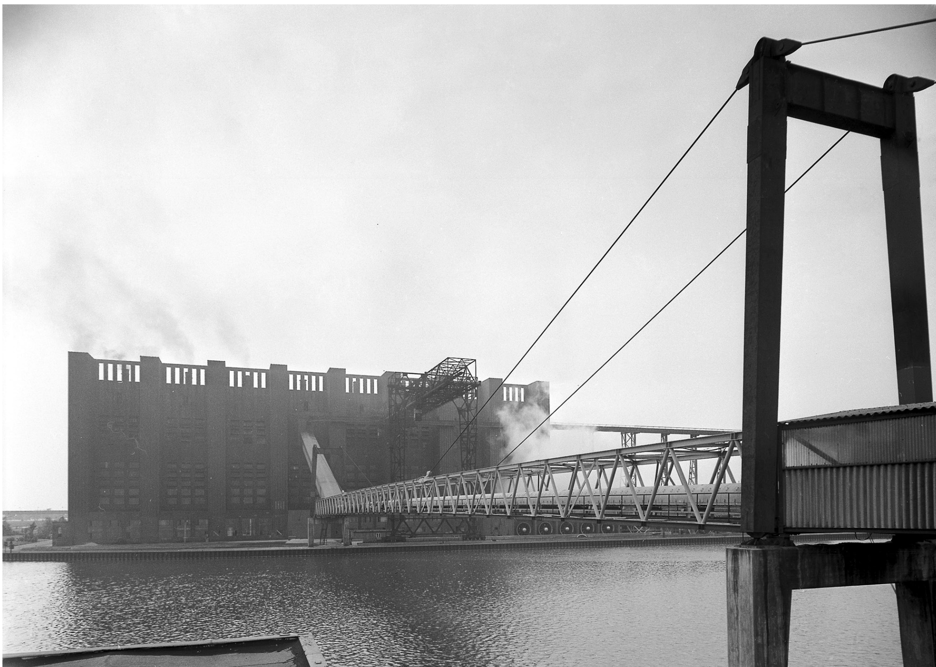
Abb. 1: Bekohlungsanlage, Volkswagen Kraftwerk, Wolfsburg 1958; © Volkswagen Aktiengesellschaft
