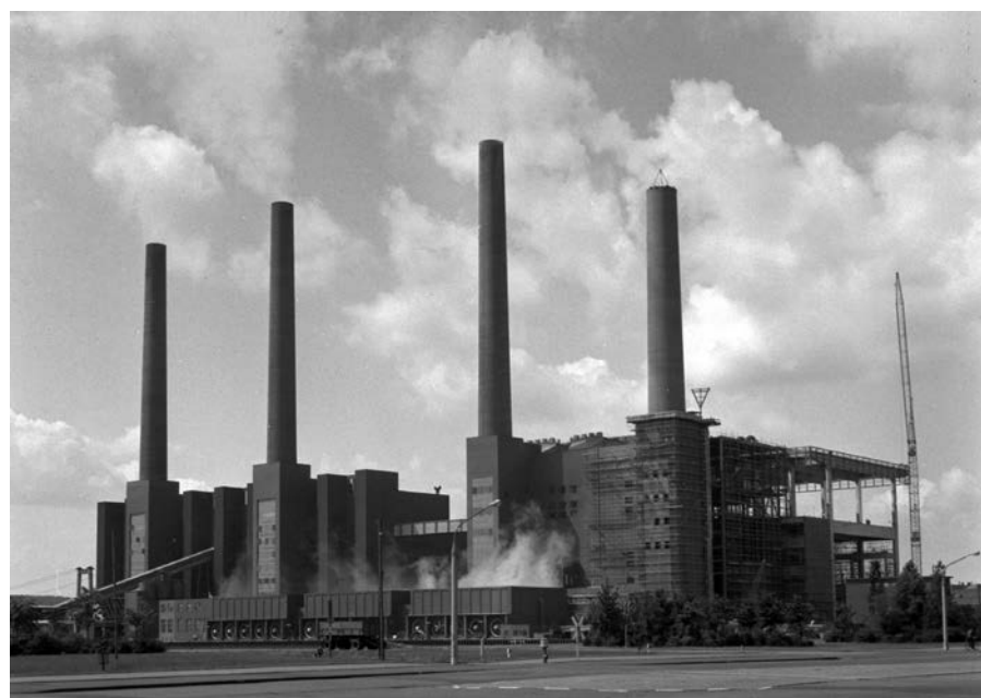
Abb. 6: Bau des 4. Schornsteins am Kraftwerk Nord (unten beschnitten), Wolfsburg 1966; © Volkswagen Aktiengesellschaft
