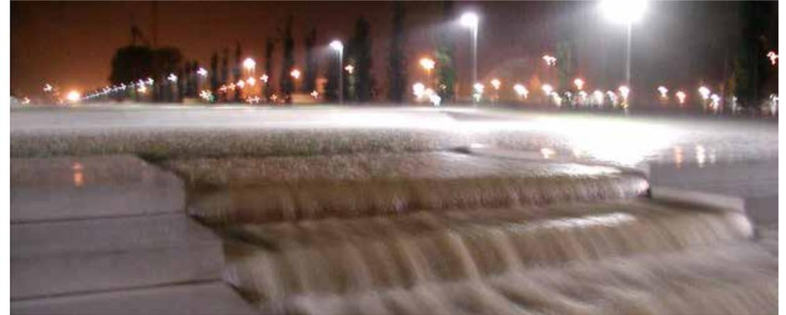
Beispiel für die oberflächige Einleitung des Regenwassers von einer Straßenfläche in eine Retentionsrasenfläche (Wassertreppe): Der Weg des Regenwassers wird sichtbar gemacht und inszeniert.
