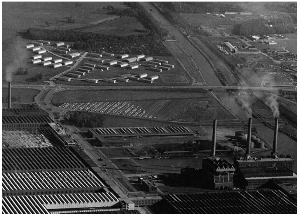
Abb 3: Luftaufnahme Unterkünfte Berliner Brücke 1963, Foto: Volkswagen Aktiengesellschaft
