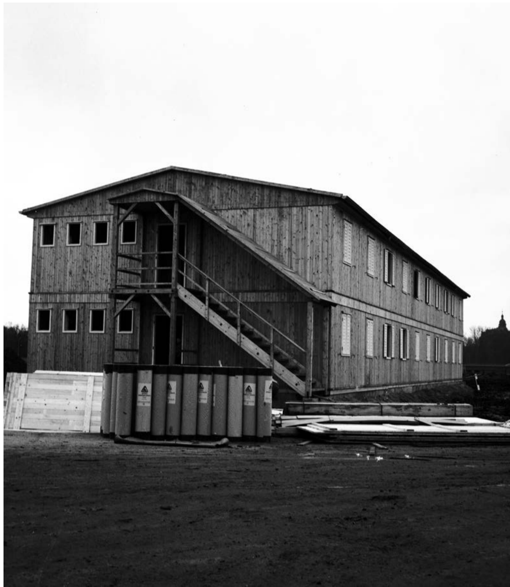
Abb 2: Unterkunft Berliner Brücke im Bau Februar 1962, Foto: Volkswagen Aktiengesellschaft
