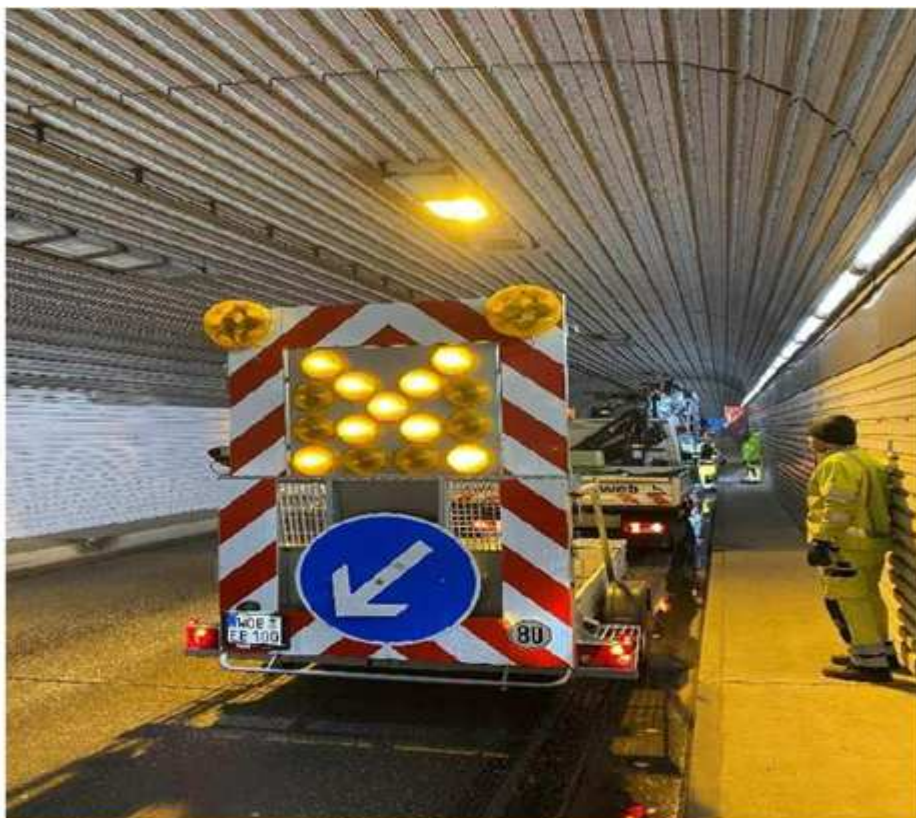
Sinkkastenreinigung im Tunnel Heinrich-Nordhoff-Straße
