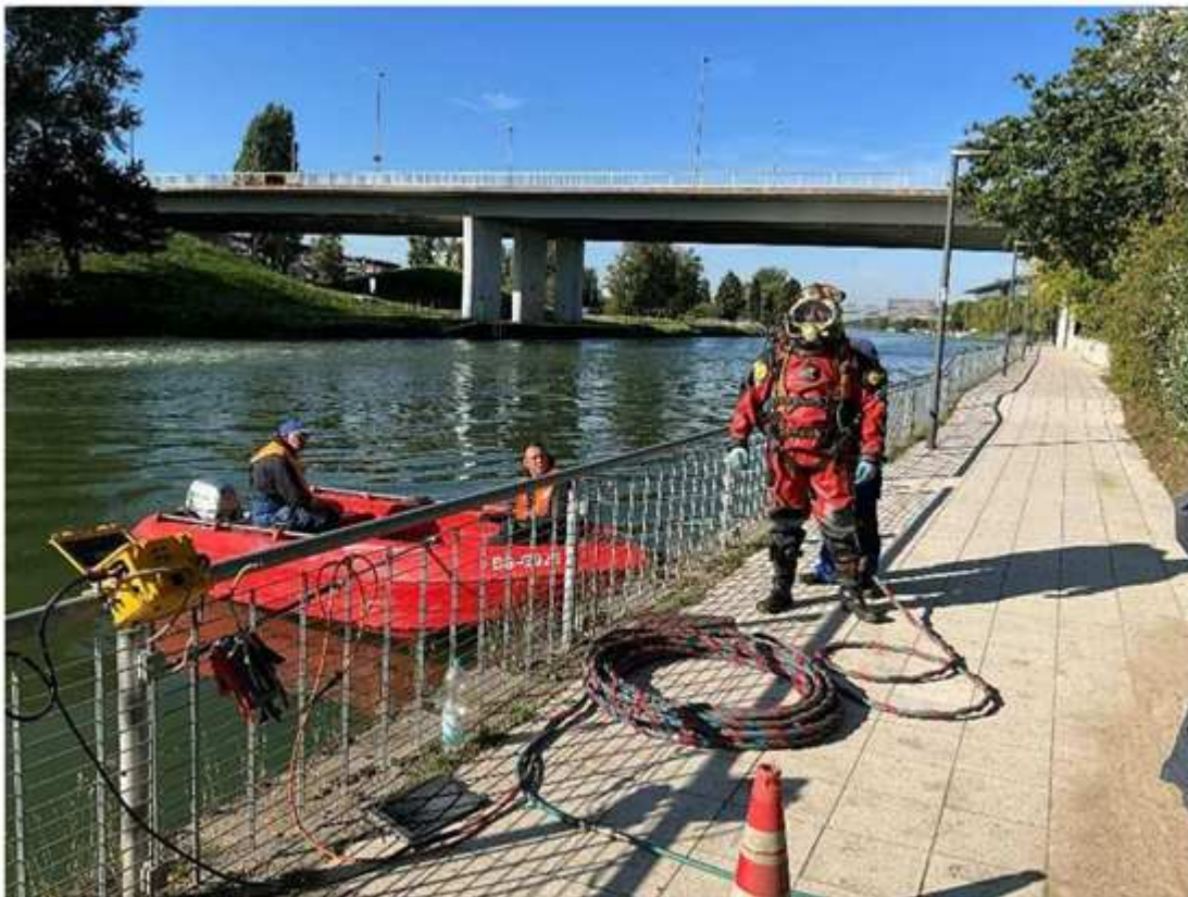
Industrietauchereinsatz über dem MLK Düker
