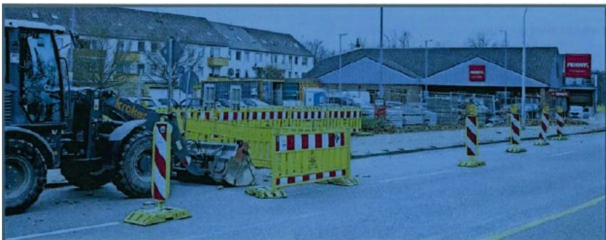
Baumaßnahme in der Schulenburgallee (Foto: R. Hermstein)
