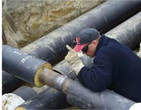
Abb. 107: links: Thermografische Befliegung Jahr 2006; rechts: Neuverlegung Kunststoffmantelrohr (KMR) im Rohrgraben [Quelle: <https://www.lsw-netz.de>]
