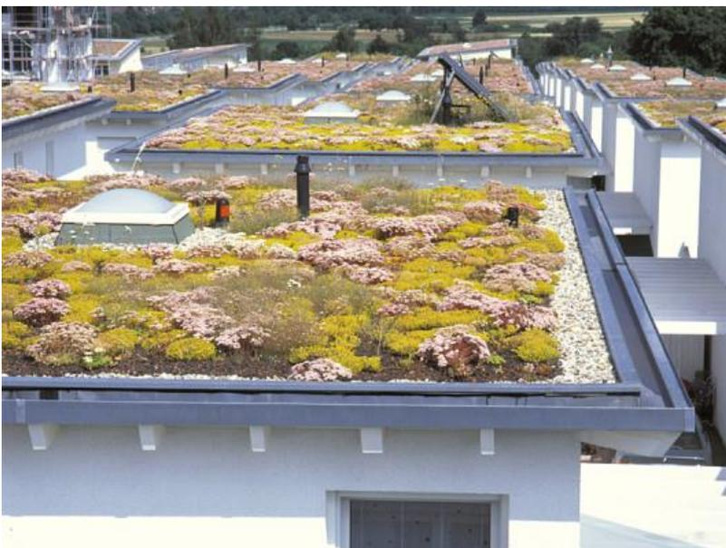
Abb. 117: Extensive Dachbegrünung (Bild: Baunetz)
