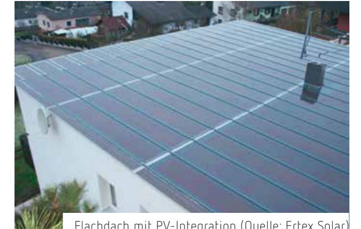
Flachdach mit PV-Integration (Quelle: Ertex Solar)
