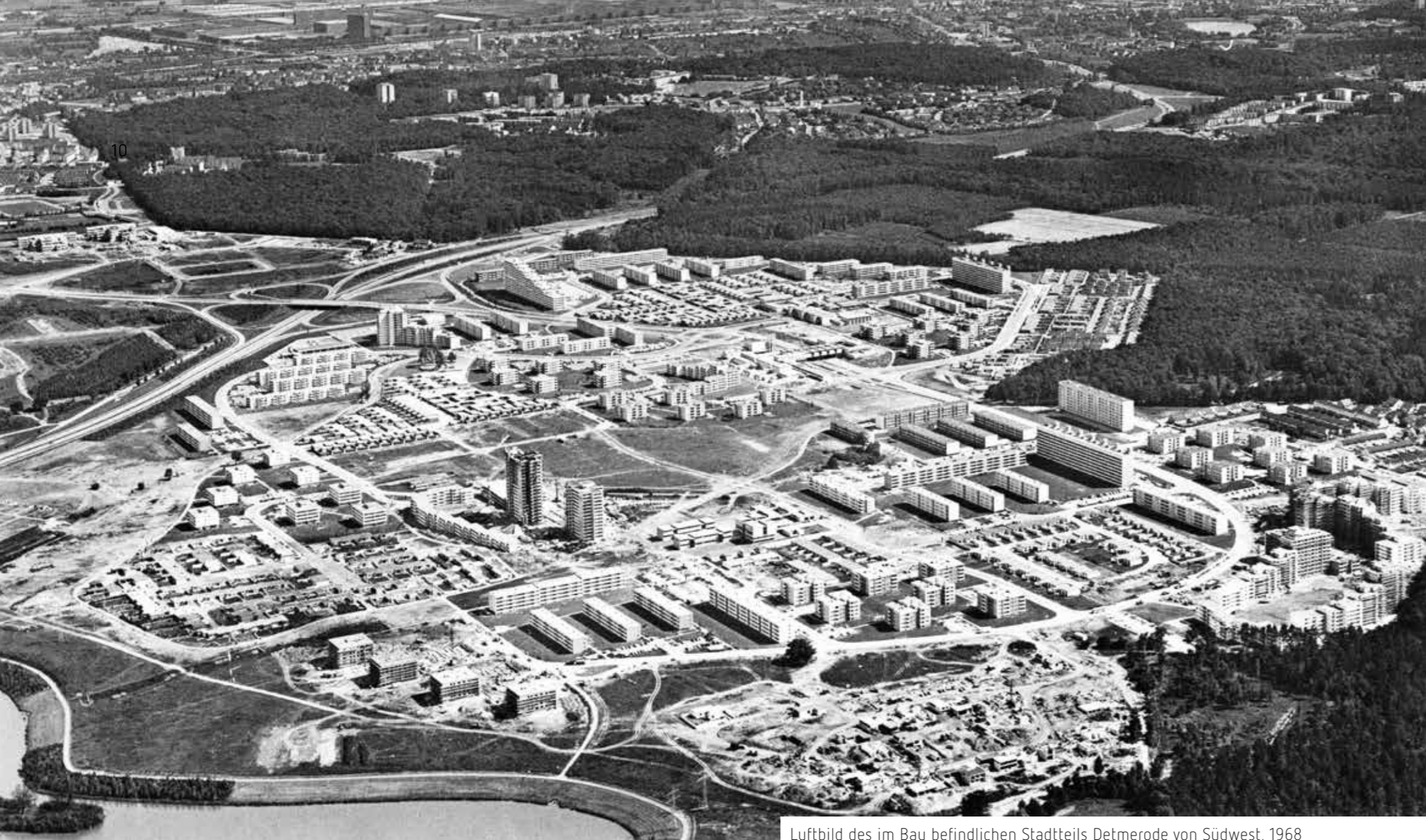
Luftbild des im Bau befindlichen Stadtteils Detmerode von Südwest, 1968
