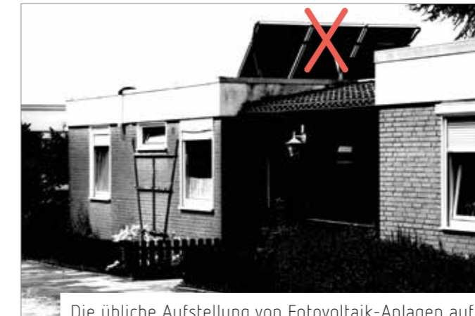
Die übliche Aufstellung von Fotovoltaik-Anlagen auf Flachdächern verändert die Dachlandschaft gravierend.
