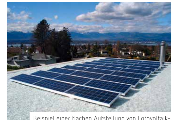
Beispiel einer flachen Aufstellung von Fotovoltaik-Anlagen auf Flachdächern (Quelle: Kösslinger Energy GmbH)
