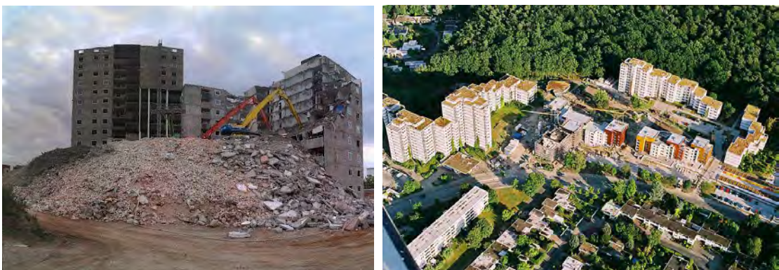
Teilabriss der Großwohnanlage „Große Burg“ und Luftbild der in Teilen umgebauten Anlage 2011 (Foto: Hans Bertram)
