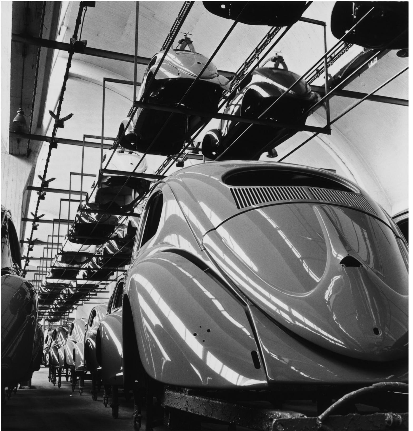
Abb. 7: Karosserien mit provisorisch befestigten Kotflügeln aus der Lackiererei auf dem Weg zur Endmontage in Halle 3. Der Transport erfolgt an Kettenförderern und auf Schlitten, April 1953; Fotograf: Peter Keetman/Kunstmuseum Wolfsburg, Dauerleihgabe der Volkswagen Financial Services AG, Braunschweig © Peter Keetman Archiv/Stiftung F.C. Gundlach
