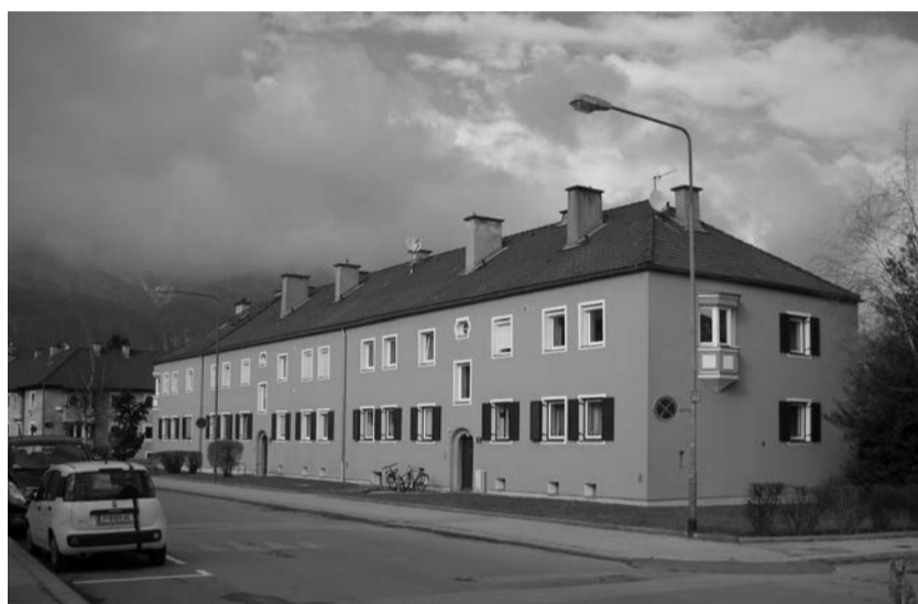
Abb. 4: Innsbruck Pradl, „Am Rain“, Süd- und Westfassade des „Block 1“ an der Turingstraße, bereits abgerissen; Foto: Michael Svehla (2015)
