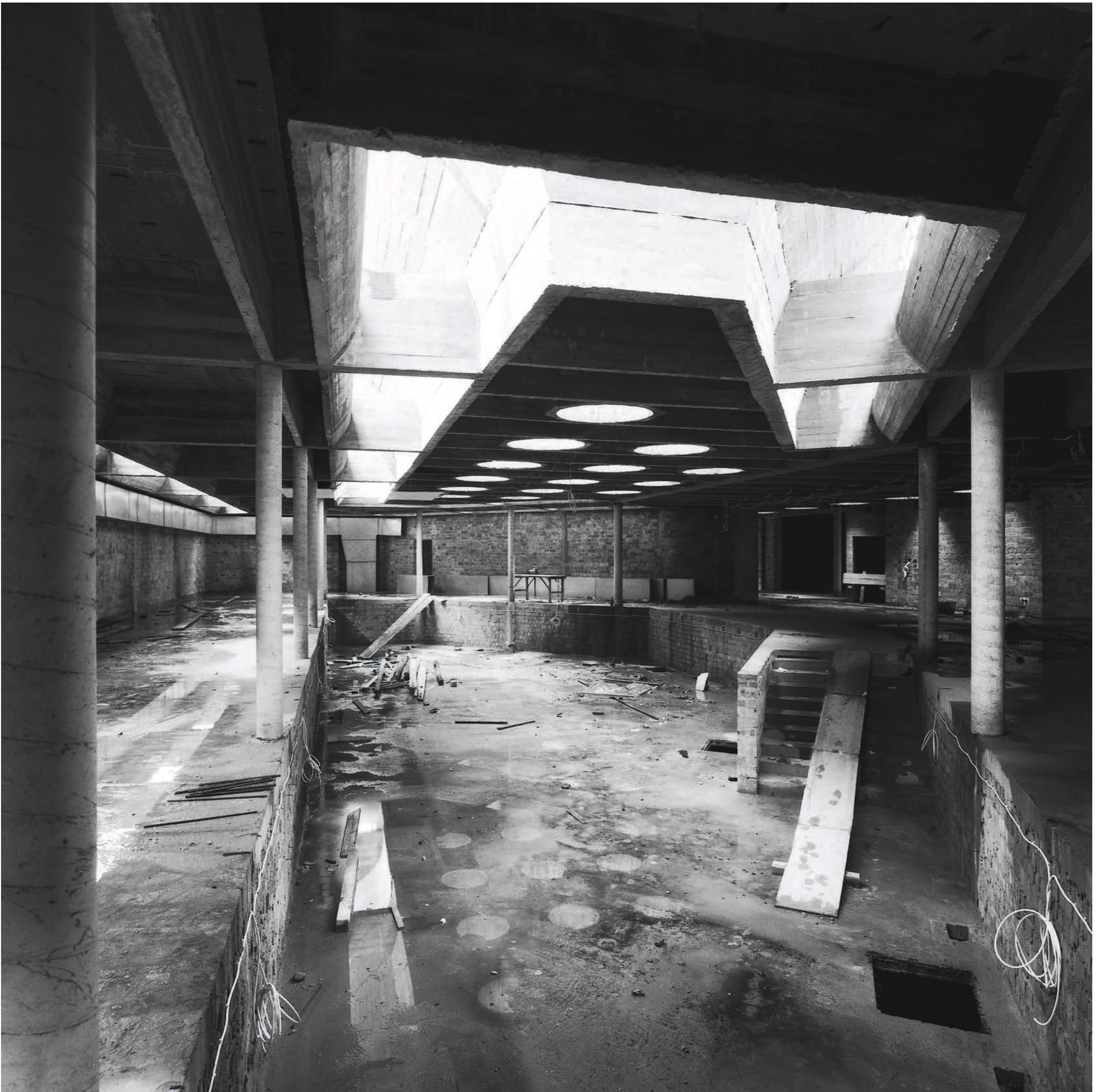
Abb. 7: Schon deutlich zu erkennen: die vertiefte Romanbibliothek; Foto: Heinrich Heidersberger, #891 Rohbau Alvar Aalto Kulturhaus, Wolfsburg 1960; Institut Heinrich Heidersberger
