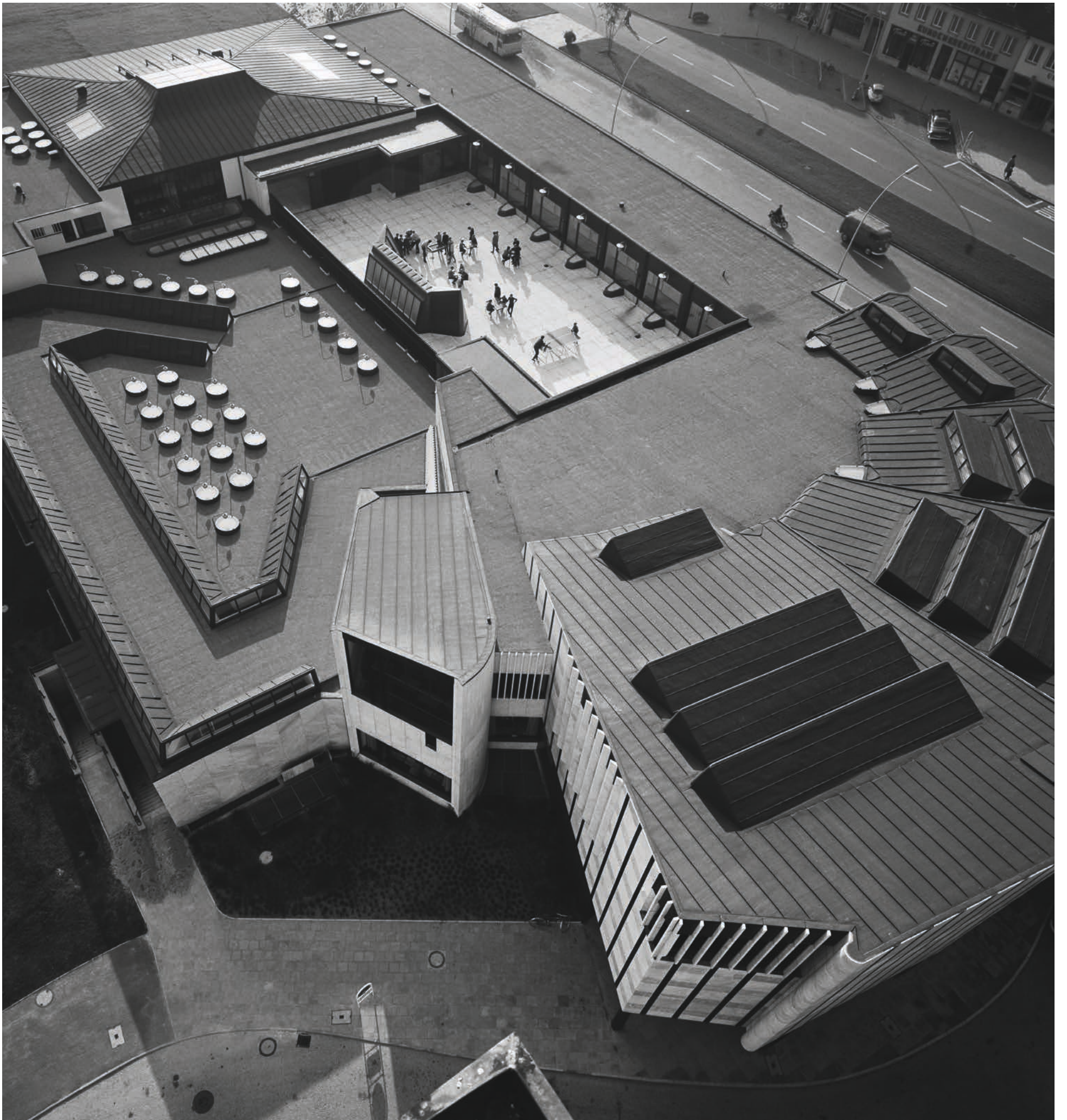
Abb. 1: Blick vom Wolfsburger Rathaus auf die Dachterrasse des Kulturzentrums; Foto: Heinrich Heidersberger, #921 Alvar Aalto Kulturzentrum Wolfsburg; Institut Heinrich Heidersberger
