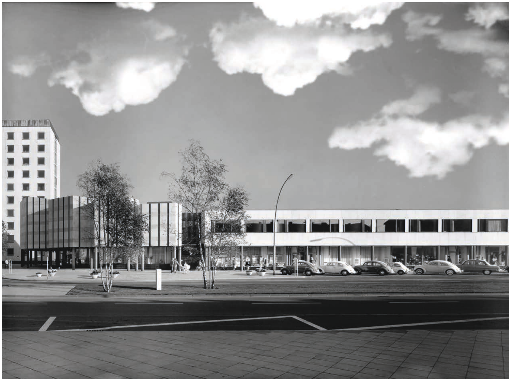
Abb. 15: Die Westseite des Kulturzentrums; Foto: Heinrich Heidersberger, #921 Alvar Aalto Kulturzentrum Wolfsburg; Institut Heinrich Heidersberger
