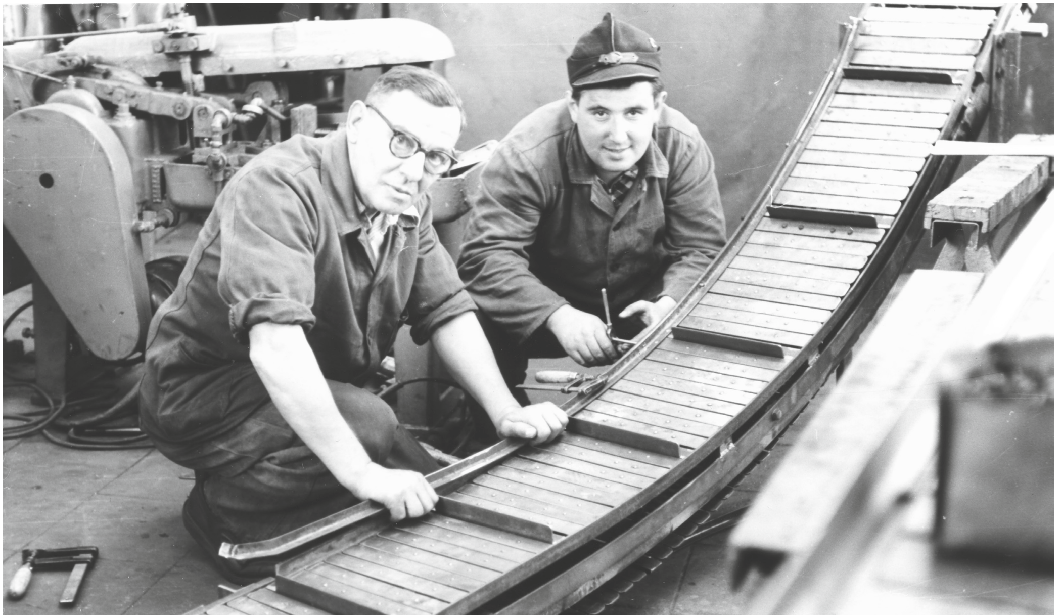
Abb. 14: Betriebsschlosser bei der Reparatur eines Förderbands, 1957; Foto: Günter Franzkowiak
