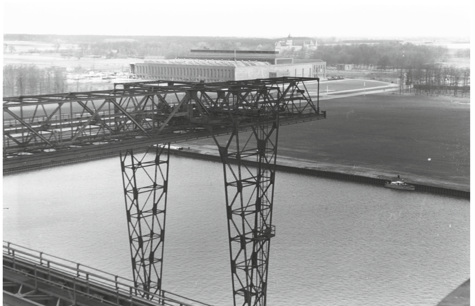
Abb. 30: Blick vom Dach des Block Süd des Kraftwerks, 1952; Foto: Günter Franzkowiak
