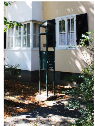
Abbildung 47: Integrierte Beleuchtungslösung, Stormhof
