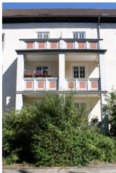
Abbildung 18: Balkone in Massivbauweise mit gemauerter Kassettenbrüstung, Scheffelhof 4+6
