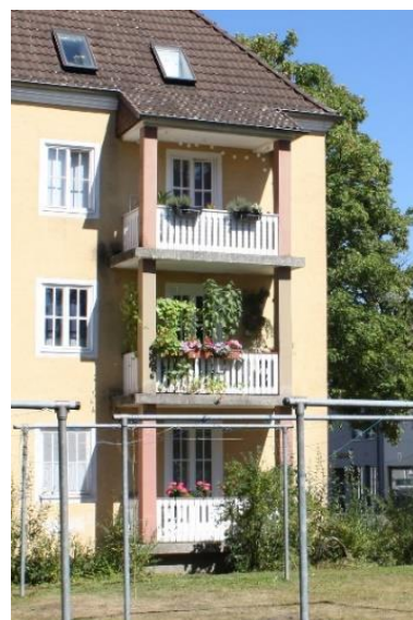
Abbildung 19: Balkone in Massivbauweise mit Holzbrüstung, Roseggerstraße 10
