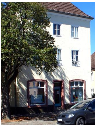
Abbildung 20: Gewerbeeinheit in der Lönsstraße, Stormhof 2
