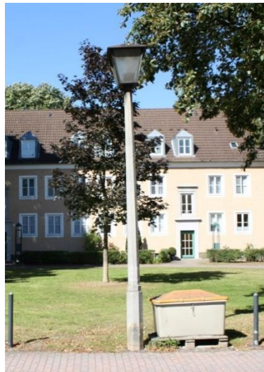
Abbildung 46: Straßenlaterne mit Betonmast, Scheffelhof
