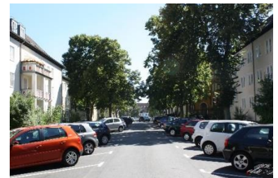
Abbildung 33: Blick in die Stichstraße Scheffelhof
