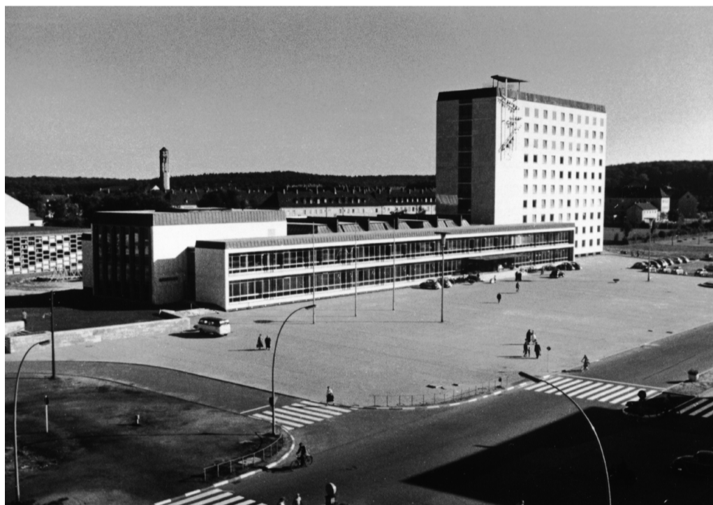
Symbol der Volkswagenstadt: Das fertiggestellte Rathaus Wolfsburg, o. A.
