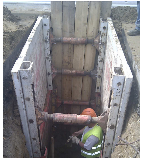
Erneuerung einer Leitung in offener Bauweise
